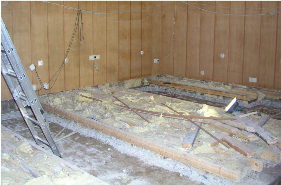
Kuva 127: Valokuva vuoden 2005–2007 peruskorjauksesta työhuoneen kaakkoiskulmaan päin. Seinärakenteen alaosat näkyvät kahden eristeistä tyhjennetyn koolausvälin kohdalla. Kuva: Käpy Paavilainen.
