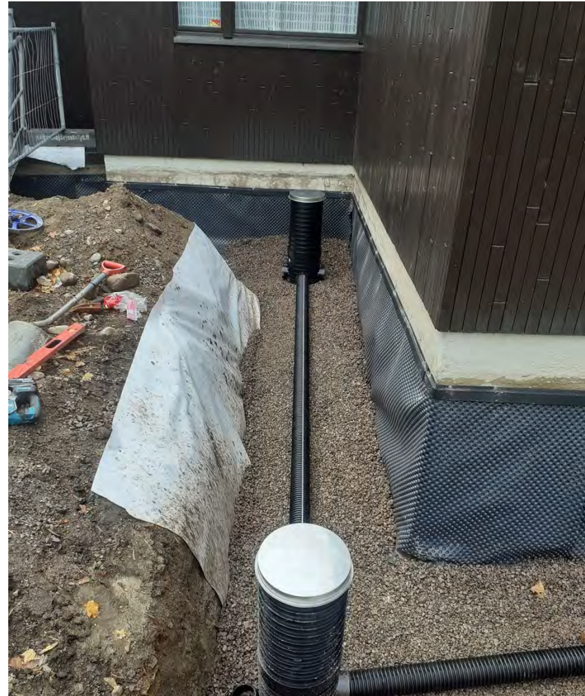
Kuva 120: Päärakennuksen uudet salaojarakenteet sisäänkäynnin vieressä. Sokkeli vuorattu patolevyllä. Kuva: Rakennustyö Karvonen 2021
