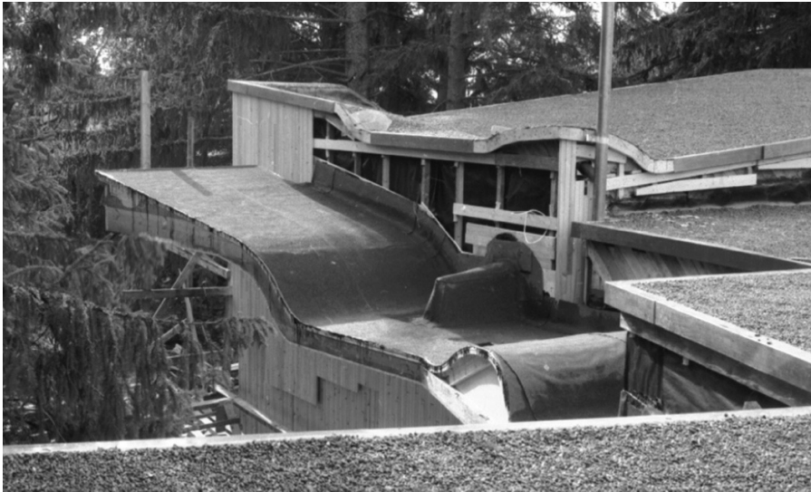
Kuva 107: Valmistuva sisäänkäyntikatos rakennuksen vesikatolta nähtynä. Kuva: Aulis Riikonen: AAS 102265
