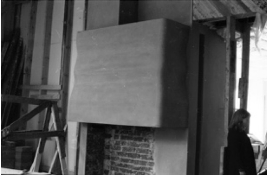
Kuva 104: Työhuoneen takka muurattu ja rapattu. Kuva: Aulis Riikonen, AAS 103254
