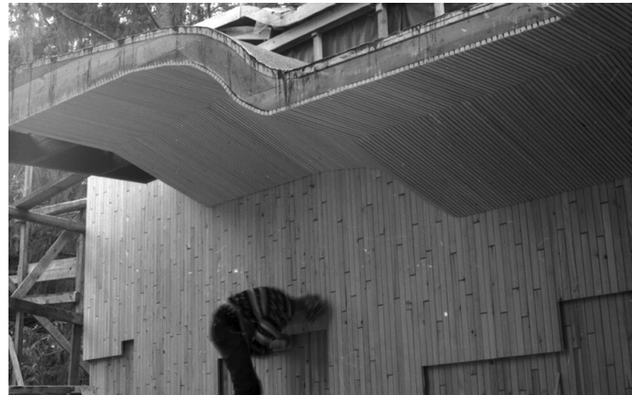
Kuva 106: Kaksinkertaisen vuorauksen viimeistelyä. Kuva: Aulis Riikonen, AAS 103249
