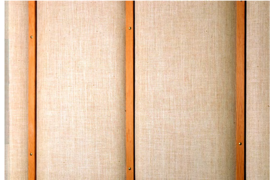
Kuva 152: Liukuovien oregonmäntylisöityä palttinakangasta. Ruokailutilan, eteiskäytävän ja välikönnön seinäpinnat ovat alun perin olleet vastaavia ilmeeltään. Kuva: Joni Rousku / AAS
