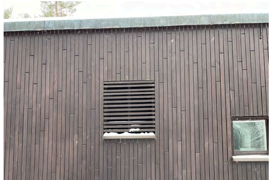
Kuva 118: Peruskorjauksen merkittävin lisäys julkisivuun ovat kaksi pohjoissivulle lisättyä raitisilmasäleikköä. Kuva: Joni Rousku / AAS
