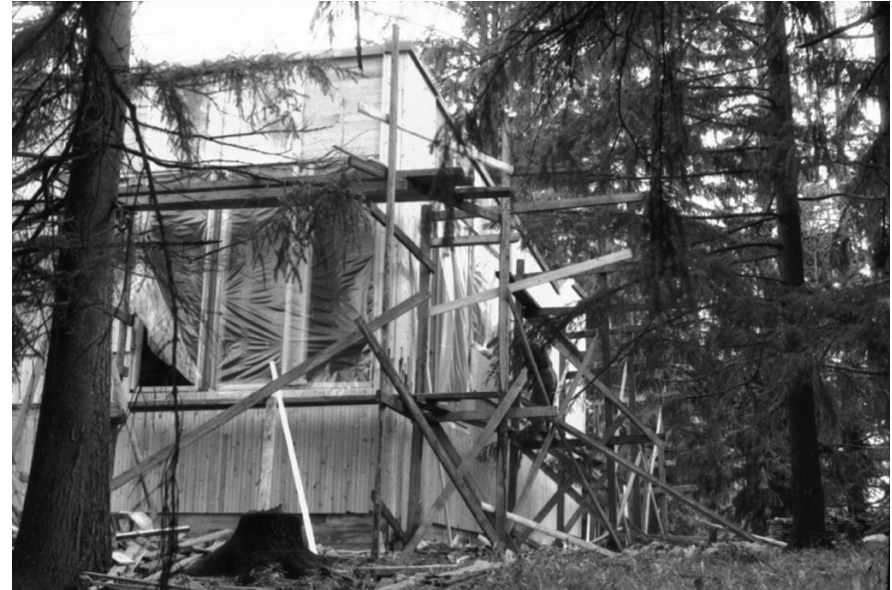
Kuva 103: Työhuoneen kulmaikkuna kesällä 1968. Telineet peittävät kaksikerroksisen vuorauksen katkaisukohdan. Suuret kuuset ovat aivan rakennusrungon vieressä. Kuva: Aulis Riikonen, AAS 103260
