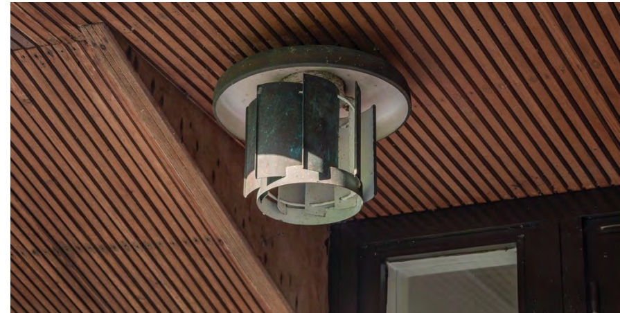
Kuva 70: Sisäänkäyntikatoksen erikoisvalaisin. Kuva: Maija Holma/AAS
