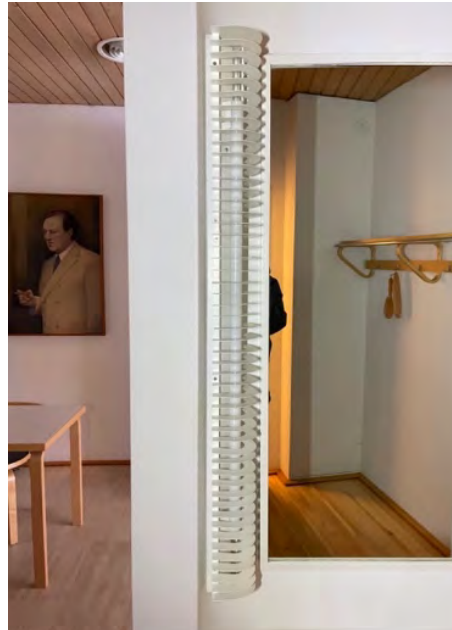
Kuva 80: Vaateilan valaisin. Valaisin kunnostettu peruskorjauksessa 2005-2007. Kuva: Joni Rousku/AAS
