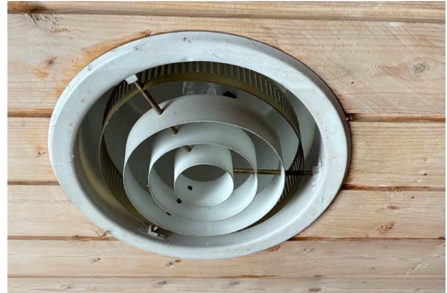
Kuva 73: Villa Kokkosen upotettu erikoisvalaisin, säleikkö ylösalaisin. Kuva: Joni Rousku
