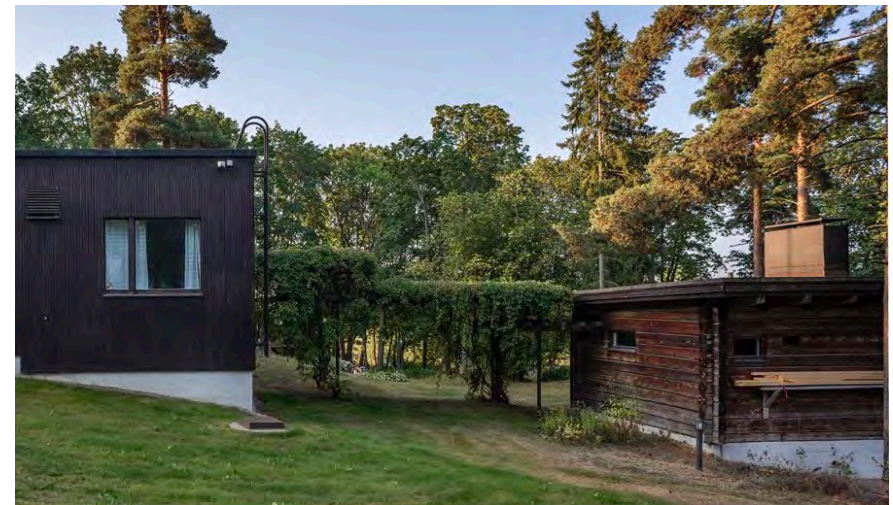
Kuva 96: Sauna pohjoispuolelta nähtynä elokuussa 2022. Kuva: Maija Holma/AAS
