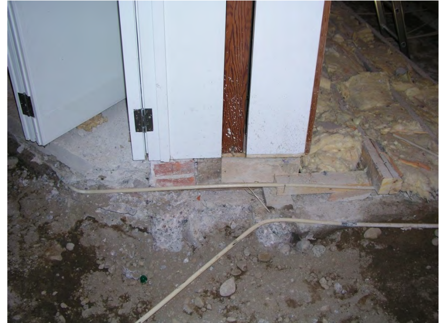
Kuva 116: Purettu travertiinipintainen lattiarakenne työhuoneen liuku- ja taiteovien edessä. Kuva: Käpy Paavilainen
