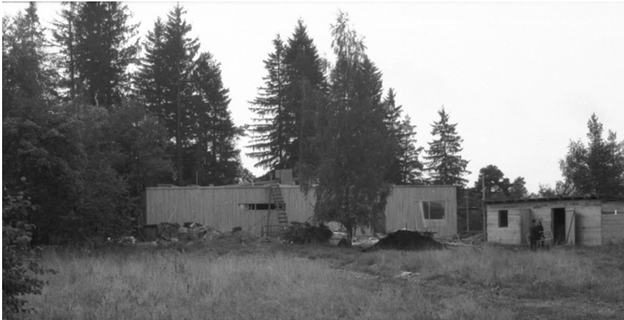
Kuva 102: Rakennusryhmän pohjoisjulkisivu. Oikealla ilmeisesti rakennusaikainen parakki/varasto. Kuva: Aulis Riikonen, AAS 103263
