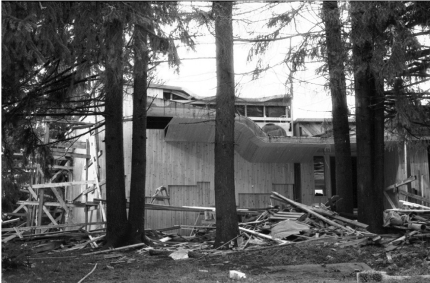
Kuva 3: Valmistuva itäjulkisivu kesällä 1968. Edessä jyrkät kuuset Kuva: Aulis Riikonen, AAS 103262
