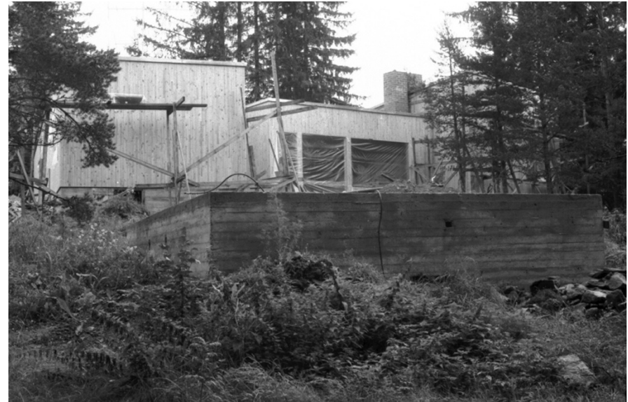
Kuva 100: Valmistuvaa länsijulkisivua kesällä 1968. Ikkuna-aukot peitetty muovilla. Etualalla saunan sokkeli, hirsirunkoa ei vielä aloitettu. Kuva: Aulis Riikonen, AAS 103255
