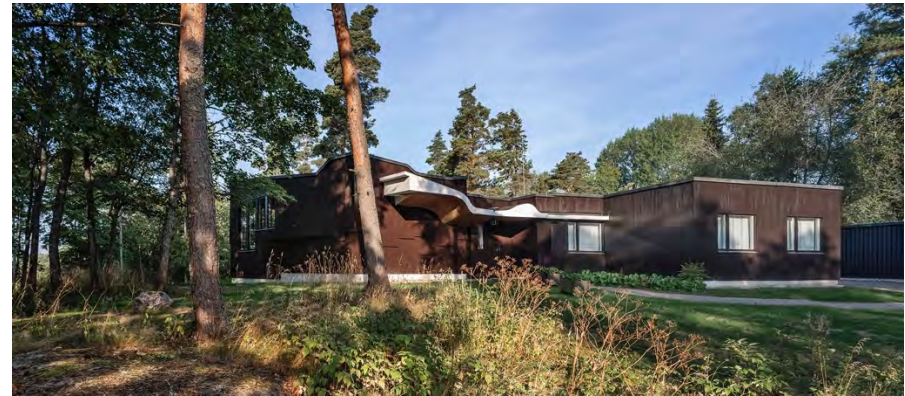
Kuva 154: Villa Kokkonen Tuulimyllyntieltä nähtynä. Kuva: Maija Holma / AAS
